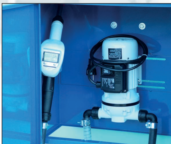
Interno del gruppo erogatore
